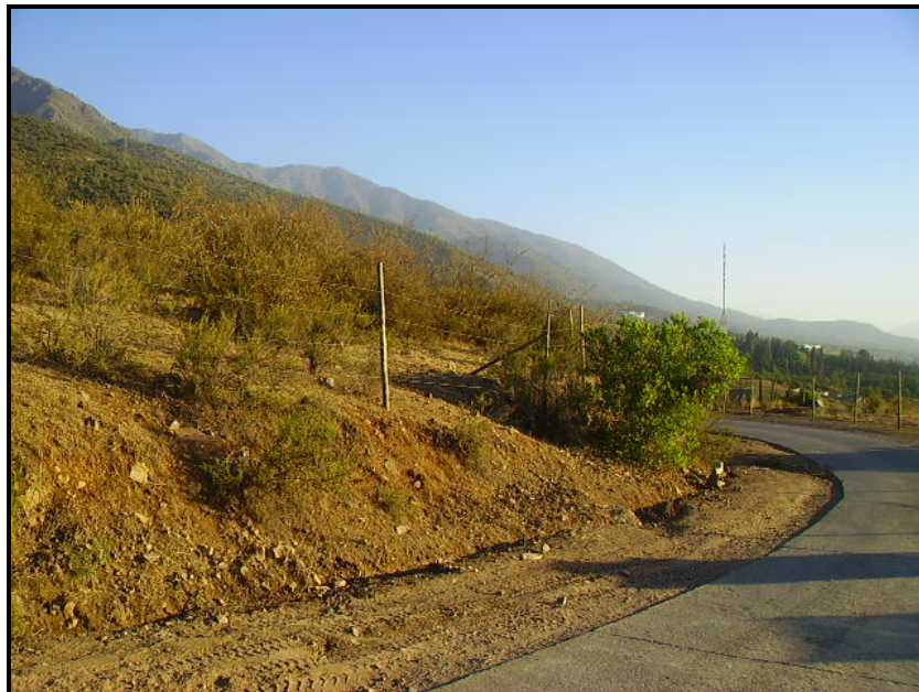
Vista al camino de acceso en el Km 1,1
