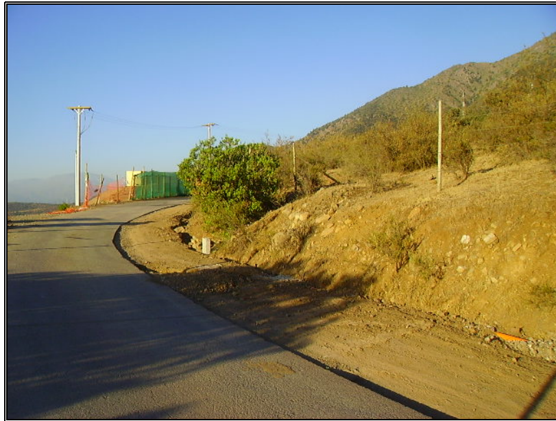
Vista al camino de acceso en el Km 1,05
